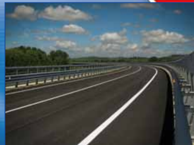
Variante di Certaldo alla ex strada statale 429 "di Val d'Elsa" - Viadotto "Fondovalle Elsa"
